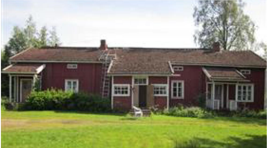
Kuva 41. Jaakola (kuvalähde: Pohjois-Pohjanmaan rakennettu kulttuuriympäristö 2015).
